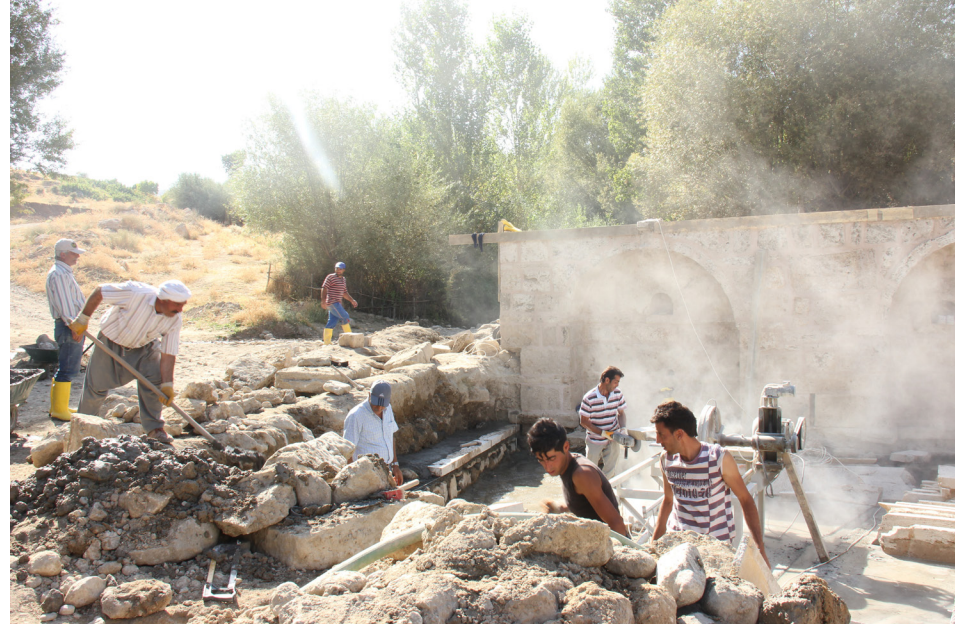
Yukarı Çeşme'de inşaat
